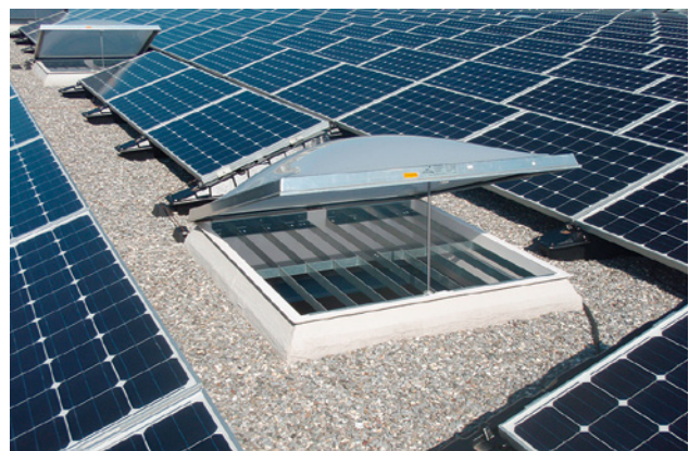
1 Oblicht, mit einem Gitter gegen Durchbruch gesichert
