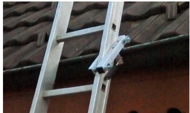
19 Sicherer Zugang aufs Dach für Arbeiten von kurzer Dauer; Leiter am Dachrand gesichert
