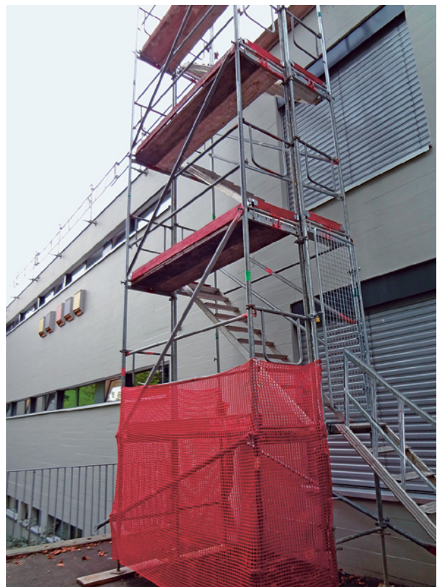
3 Sicherer Zugang über einen Treppenturm
