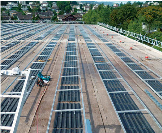
2 Montage einer Solaranlage mit umlaufendem temporärem Seitenschutz am Dachrand
